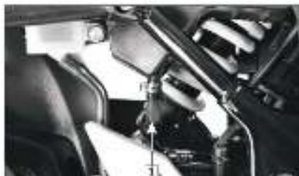
1. Tubo de drenaje
